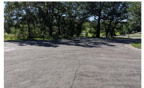
Facing SE; intersection of Chatsworth and E Como Blvd
